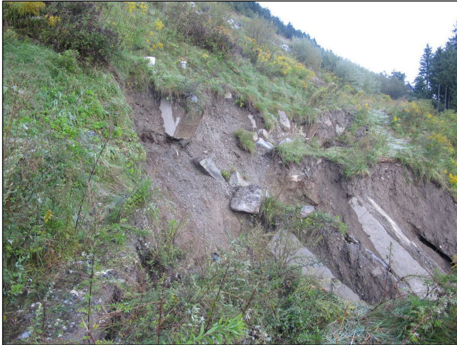
Abb. 9: Rückschreitende Erosion und flächige Wasseraustritte, 15.09.2017
