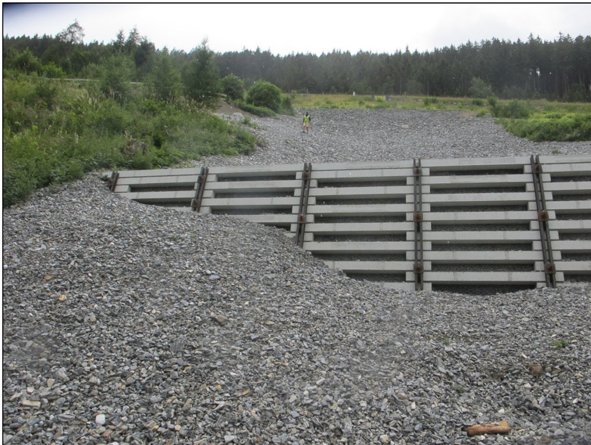
Abb. 21: Fertig abgedeckte Erosionsrinne
