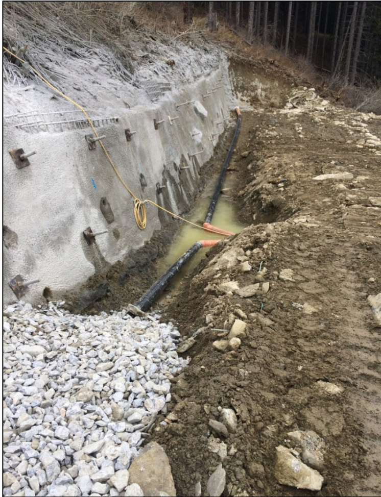
Abb. 18: Spritzbetonankerbalken
