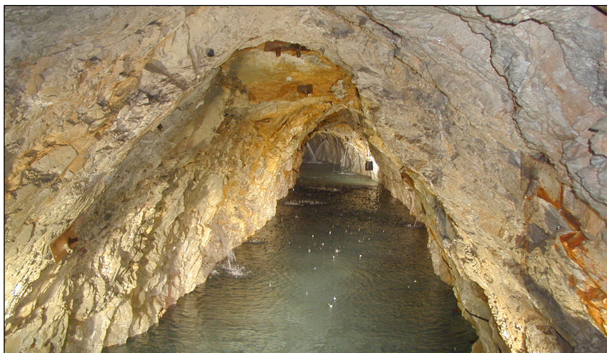
Foto 4: Moderne Stollenfassung der Bergwässer aus dem Bettelwurfmassiv (Karwendel) der Gemeinden Hall in Tirol und Absam
