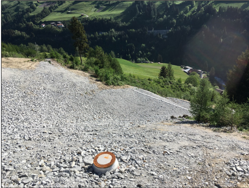
Abb. 20: Fertig abgedeckte Erosionsrinne
