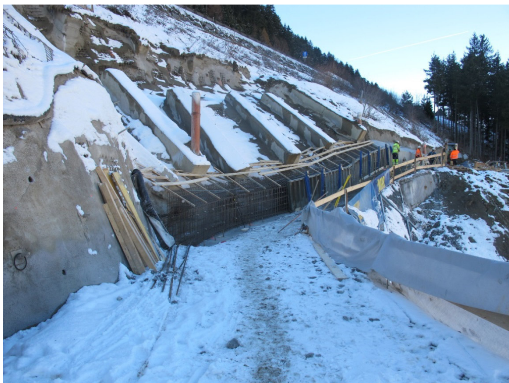
Abb. 17: Herstellung von Ankerbalken aus Ortbeton und Spritzbeton, Ankerlänge bis 60 m
