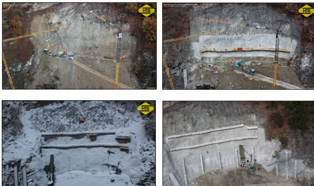
Abb. 7: Bauablauf (Webcam HTB)
