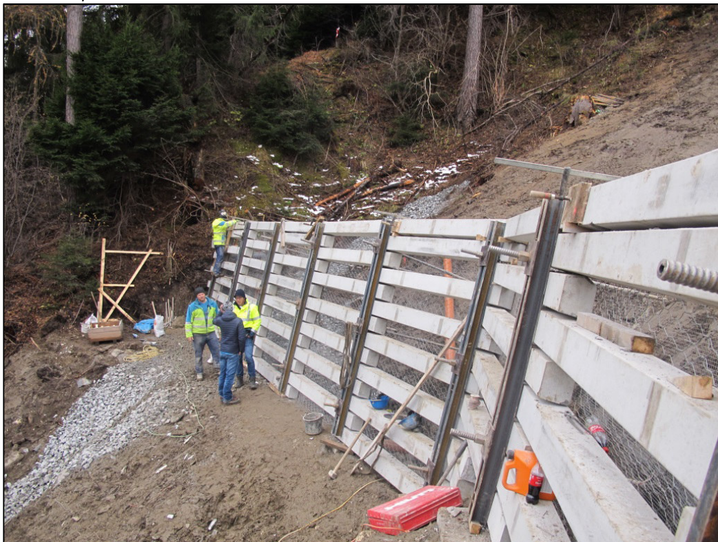
Abb. 19: Herstellen von 3 Ankerwänden mit Stahlbetonbalken und Hinterfüllung mit Kies
