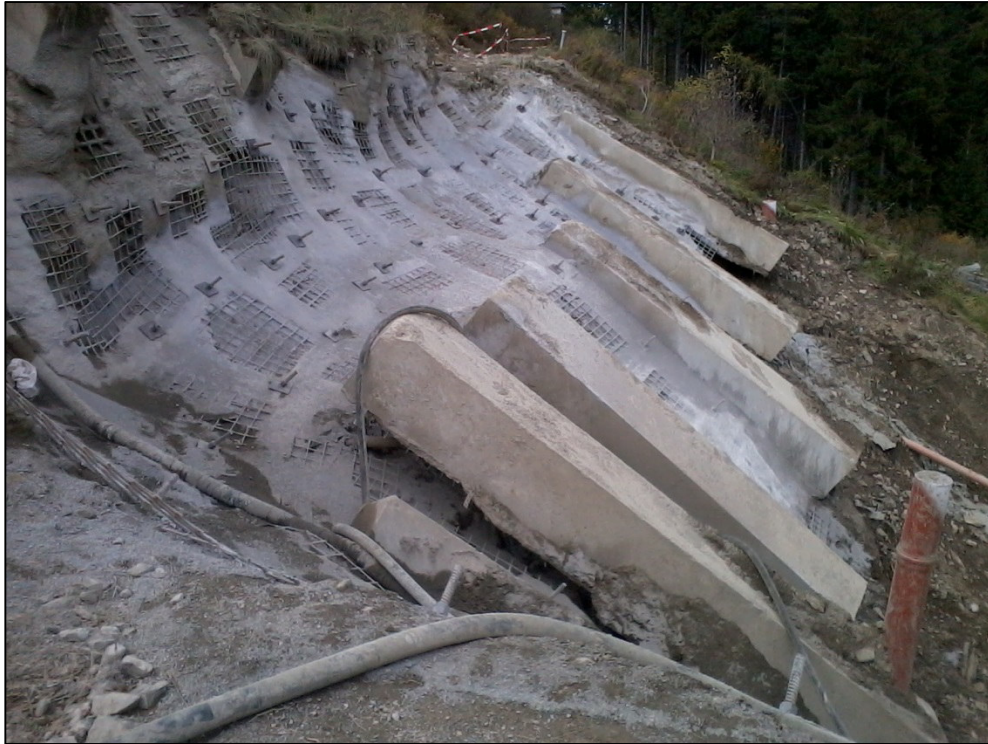
Abb. 13: Sicherung des Anbruches mittels offener Spritzbetonsicherung
