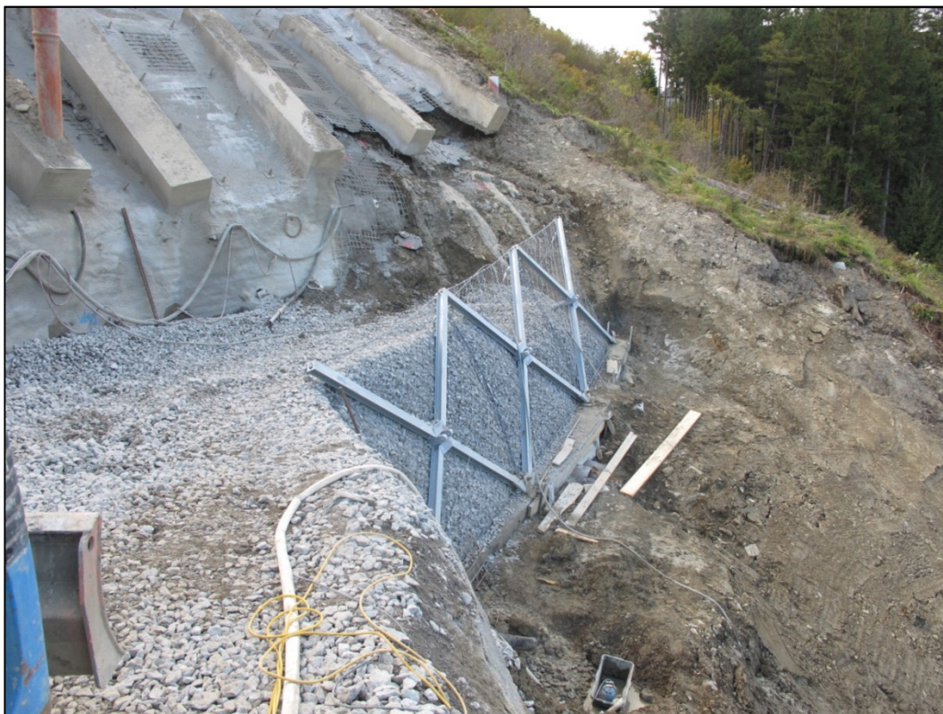
Abb. 14: Absicherung des Anbruches mittels Kies und Herstellen einer Zufahrt zur linken Talseite
