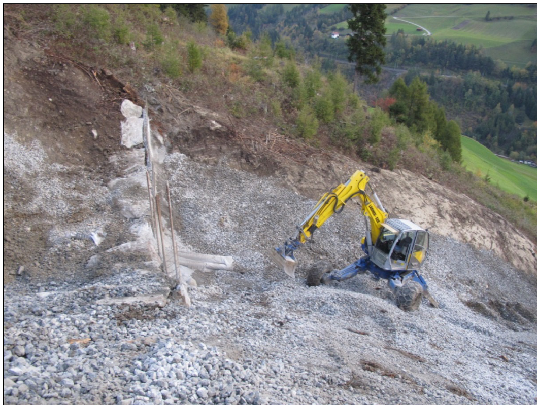
Abb. 16: Aufräumen der Rinne und Aufbringen von Kies; Verlegen von Rohren im Rinnentiefsten und Herstellen eines verankerten Fußes für die steile Böschung zu den Ankerlisenen
