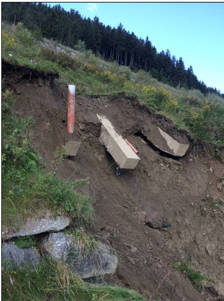
Abb. 8: Rückschreitende Erosion, 14.09.2017
