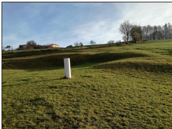
Abb. 3: Rutschung Daxböck, Rutschfläche II mit Messpfeiler 5 (vorne) und 4 (hinten)
