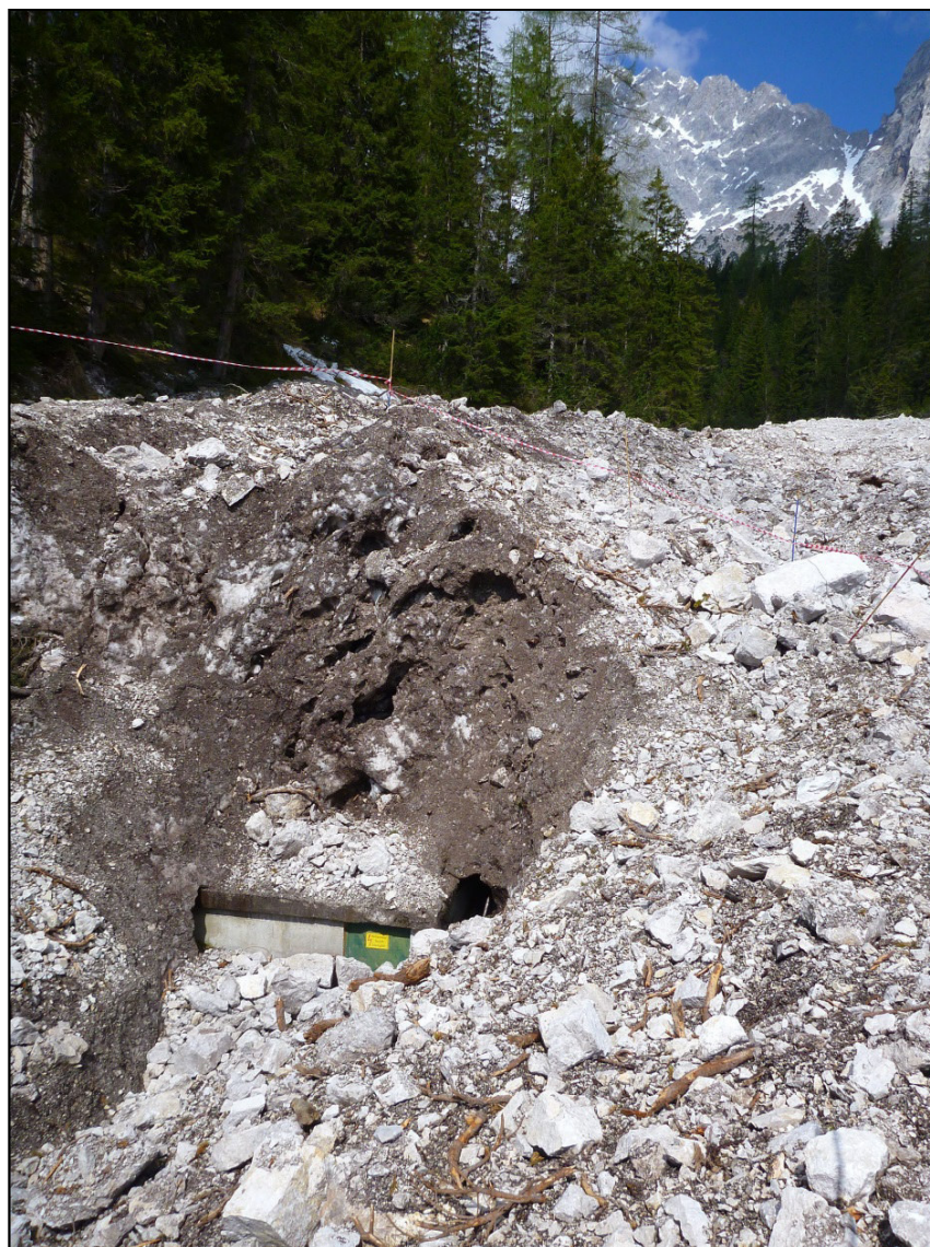
Foto 3: Verschüttung einer Trinkwasserfassung durch den Alpl-Felssturz 2011 im Gemeindegebiet von Wildermieming.
