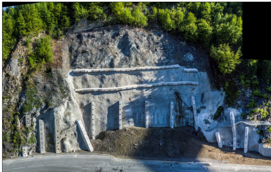
Abb. 8: Luftbild des zentralen Felssturzbereiches nach Fertigstellung der Sanierungsarbeiten
