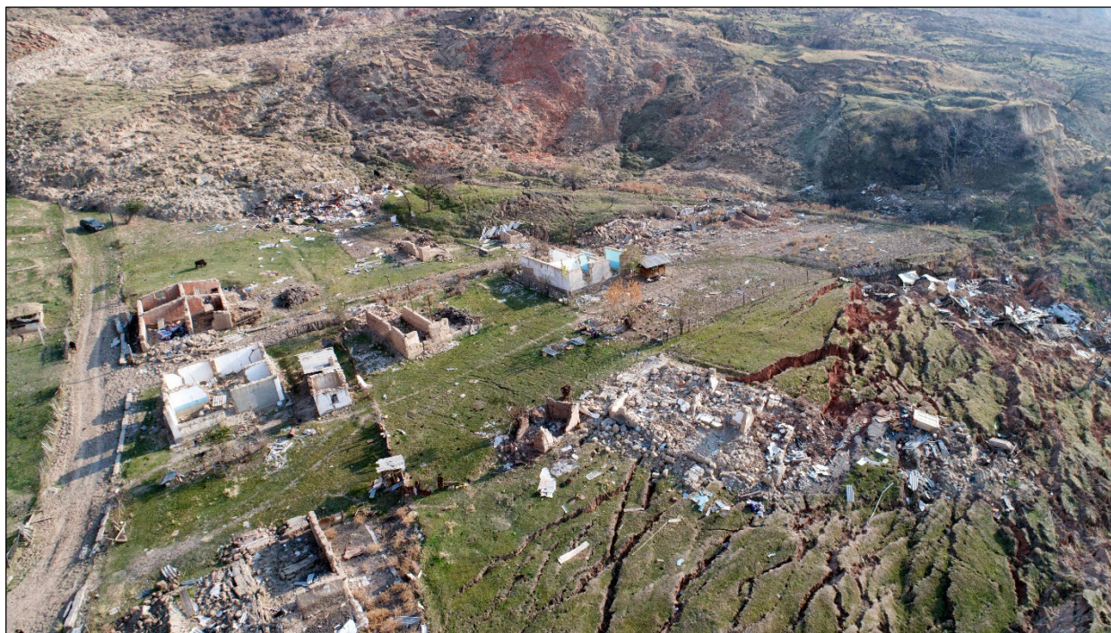
Abb. 1: Auswirkungen der Koitash Rutschung vom April 2017 (Region Mailuu Suu, Kirgistan).
